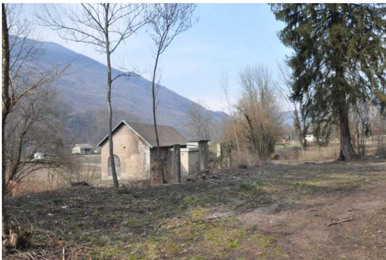
Vue générale de la centrale d'Argentine 1.
