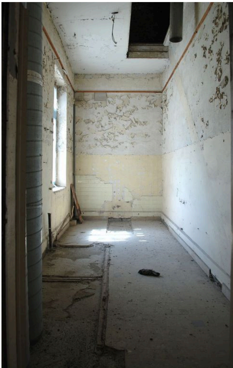
Second étage, sanitaires désaffectés
