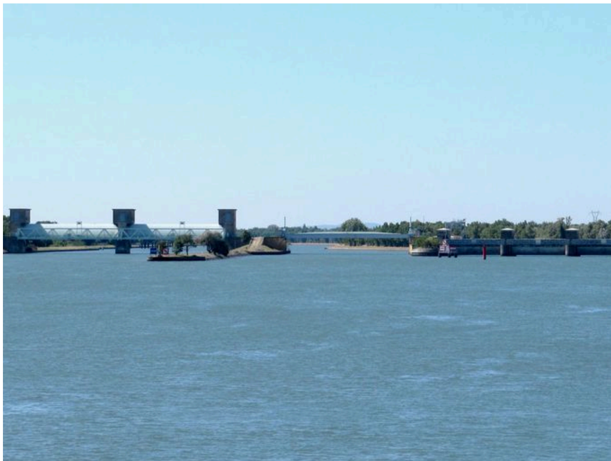
Vue générale des barrages de Donzère (depuis l'amont)
