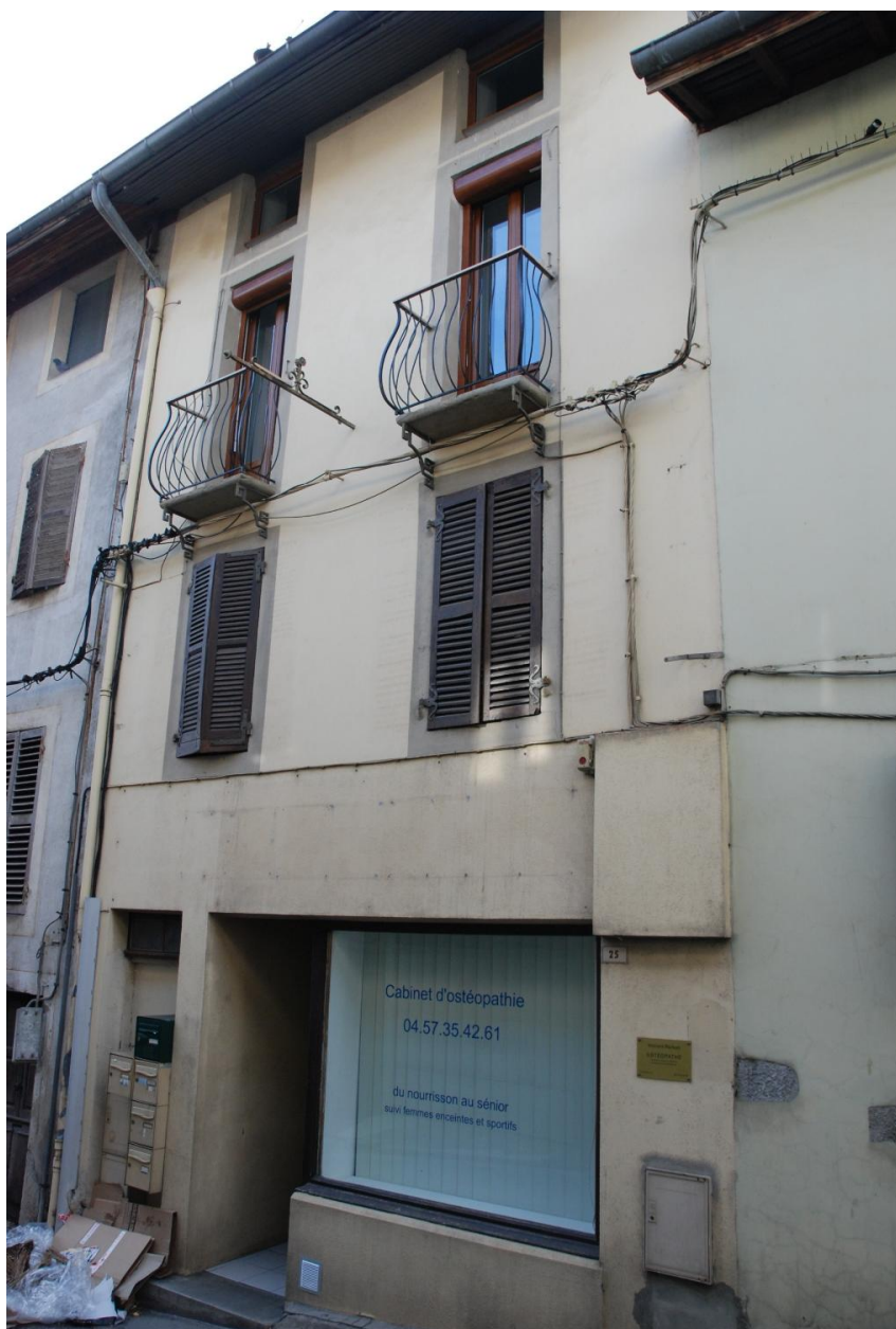
Maison, immeuble 25 rue Jean-Louis Bouvet (2018 E1 274).
