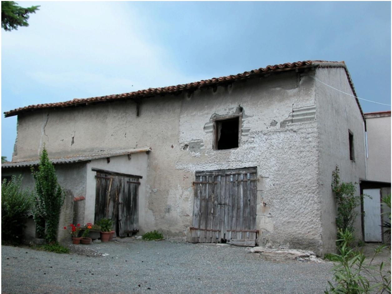
Le Bourg, maison (1988 C 156, 157, 201, 202 partie), non repérée. Dépendance.
