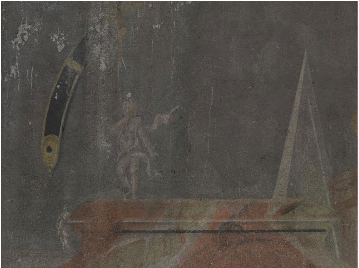
Mur ouest, partie centrale : détail
