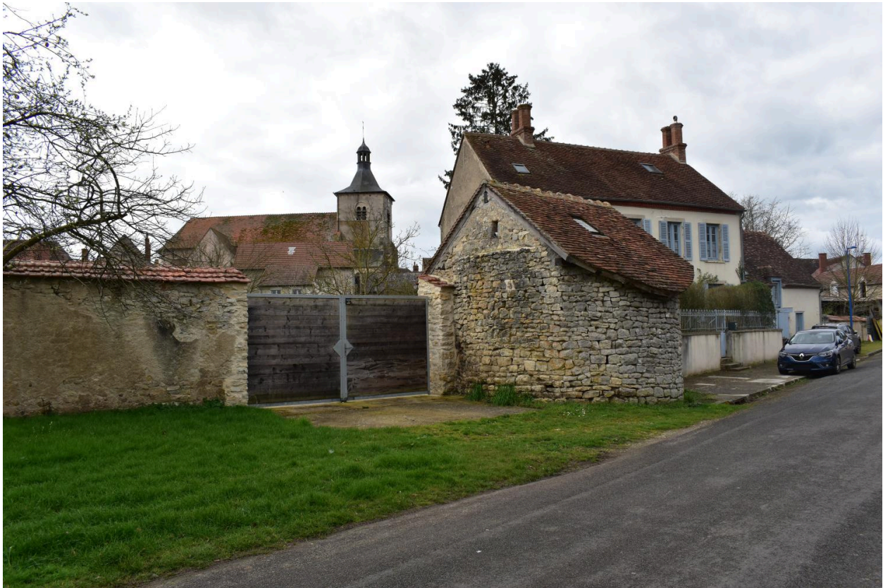
Tour, vestige de la fortification d'agglomération du Veudre, parcelle cadastrale B01 : 1343, donnant sur la place du Champ de Foire. Vue vers l'ouest.
