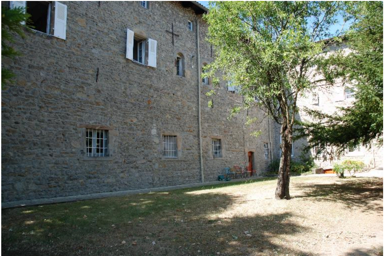
Vue d'une partie des bâtiments depuis le nord-est.
