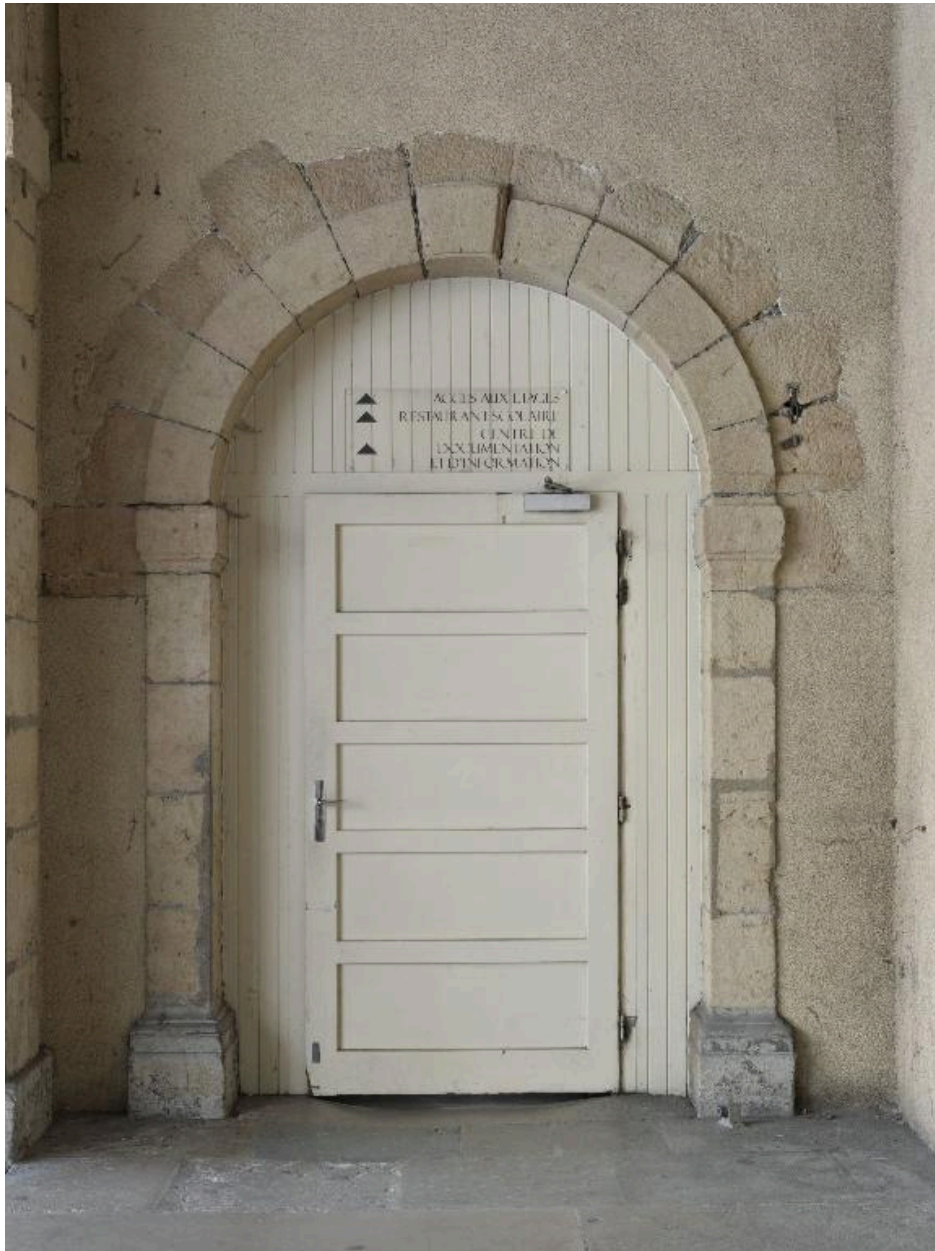
Cour d'honneur, galerie sud : porte ouvrant sur le couloir de l'escalier D
