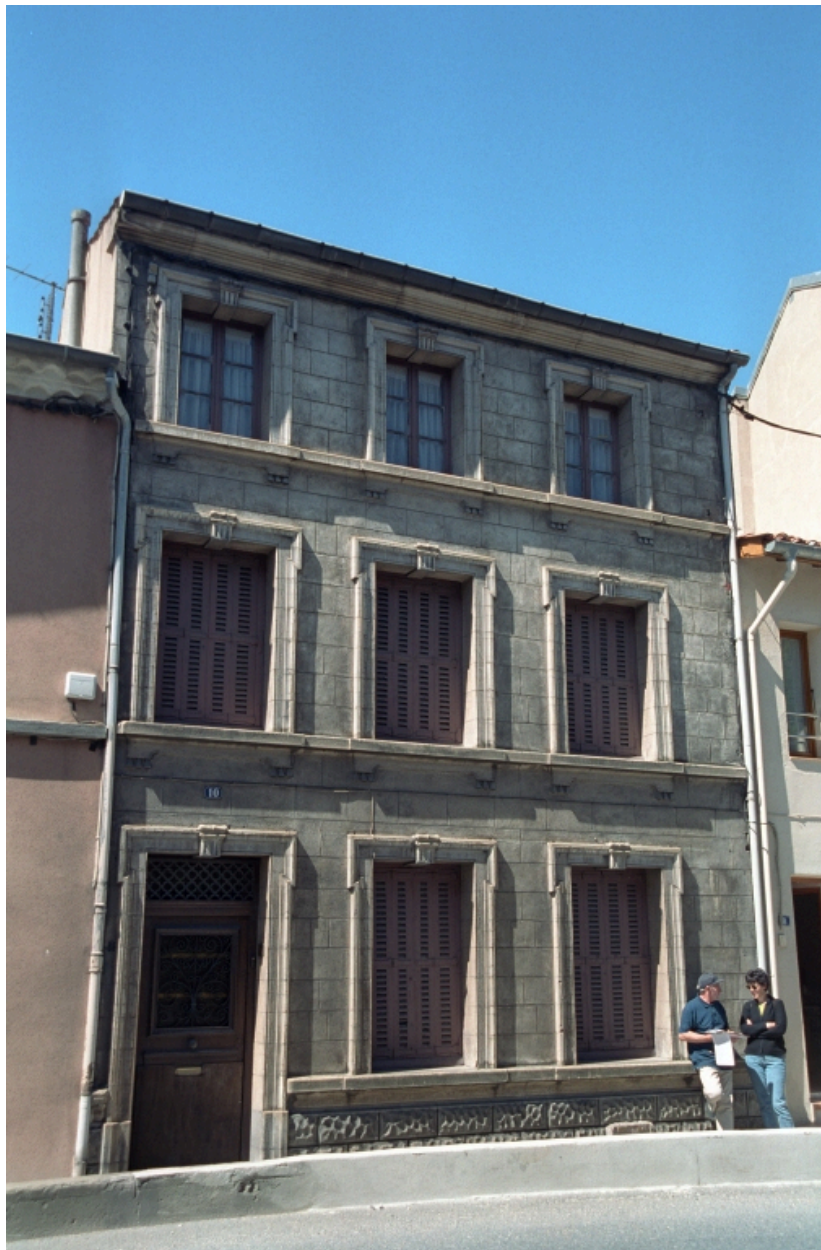
Boën, îlot 12, Clermont (rue de) 10. Vue générale de la façade sur rue.
