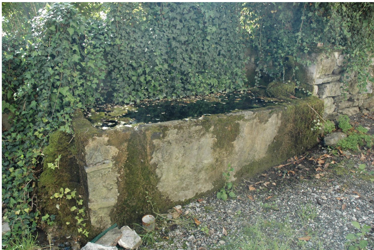
Bassin (fontaine, abreuvoir) (2018 B1 378).
