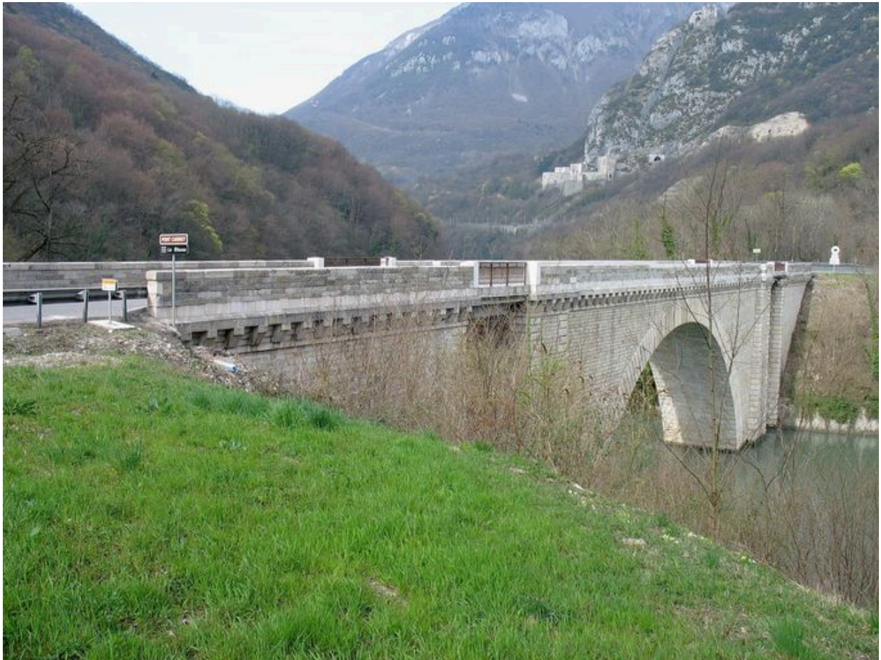
Vue générale de 3/4, côté amont (depuis la rive gauche)
