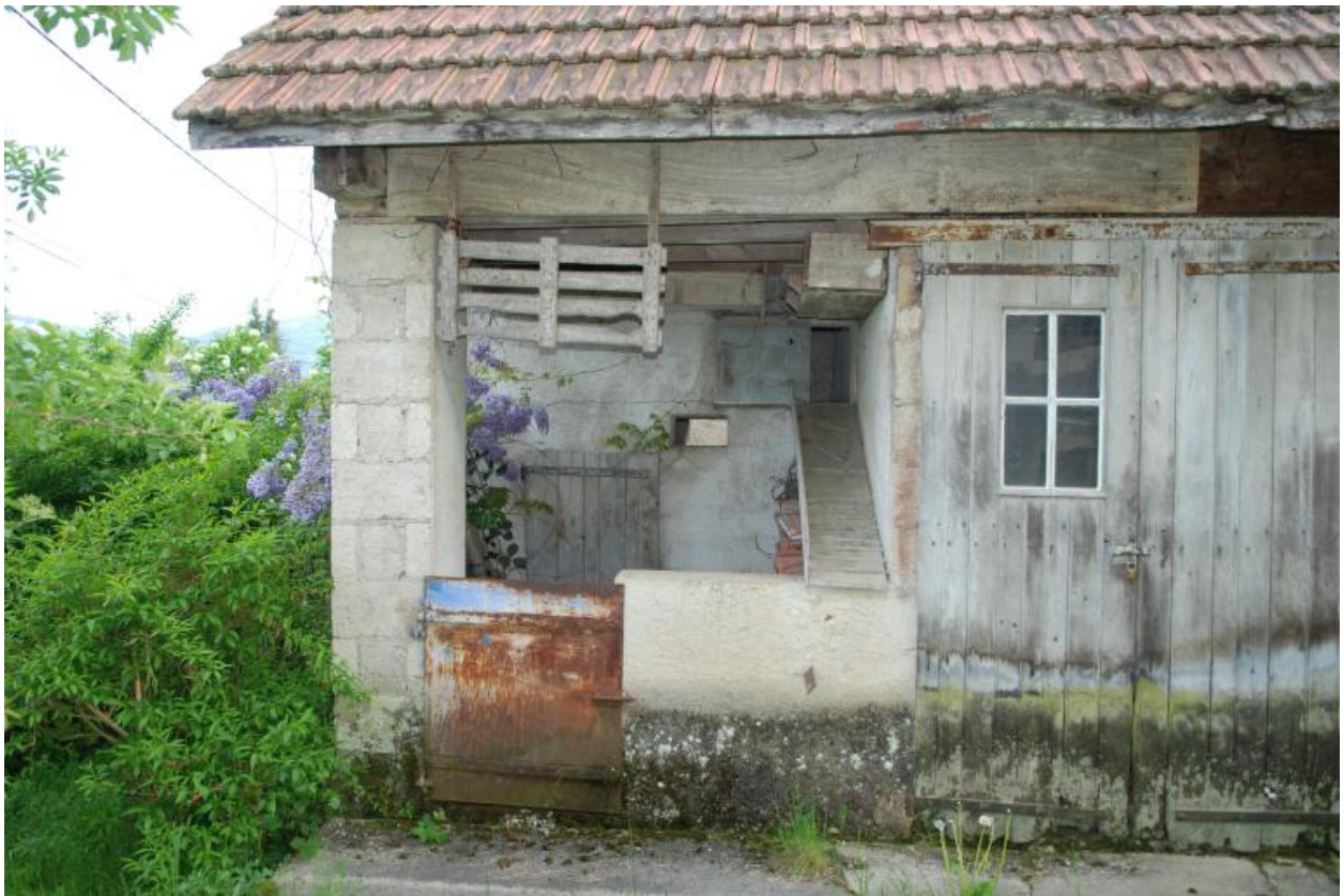
E6 431, 388, ferme. Vue partielle du bâtiment : porcherie et escalier pour le poulailler.
