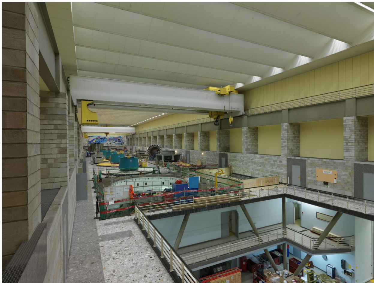
Plafond alvéolé de la salle des machines
