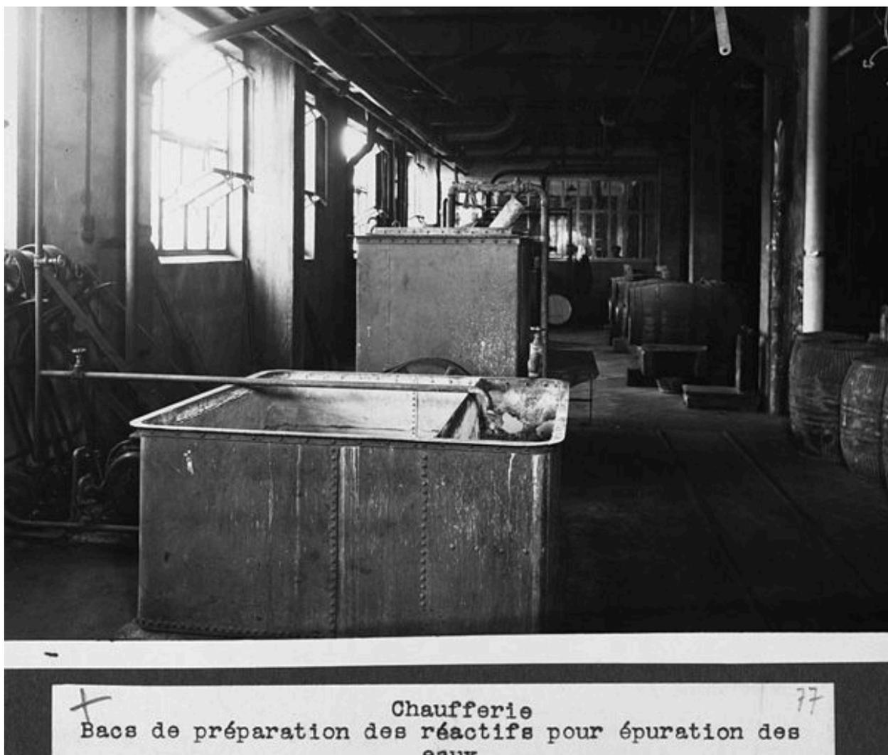
Chaufferie. Bacs de récupération des réactifs pour épuration des eaux. Photogr., vers 1960
