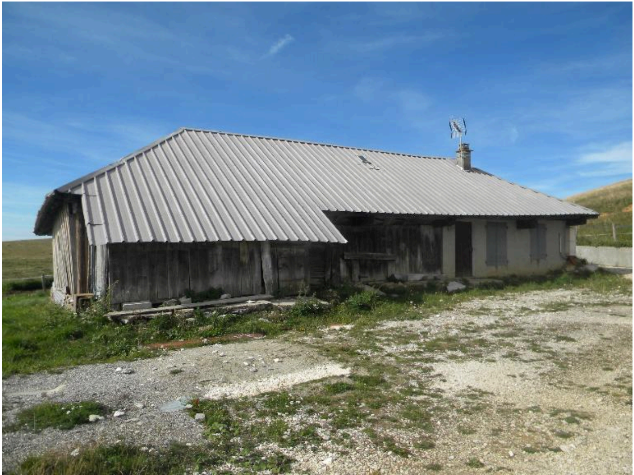
Vue d'ensemble du bâtiment de l'ancienne étable.
