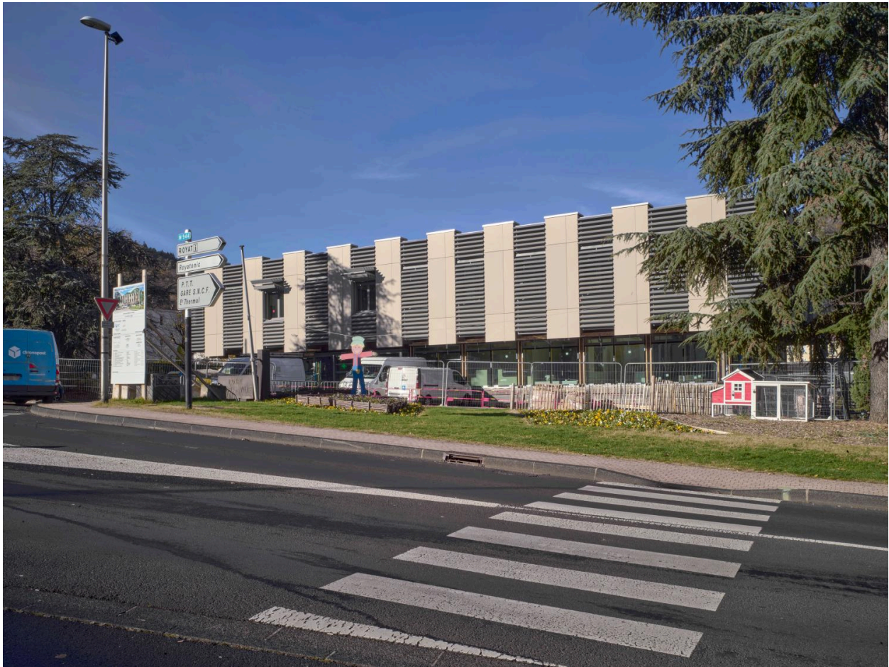
Façade antérieure de l'hôtel de ville de Royat, depuis le boulevard Barrieu, en 2023.
