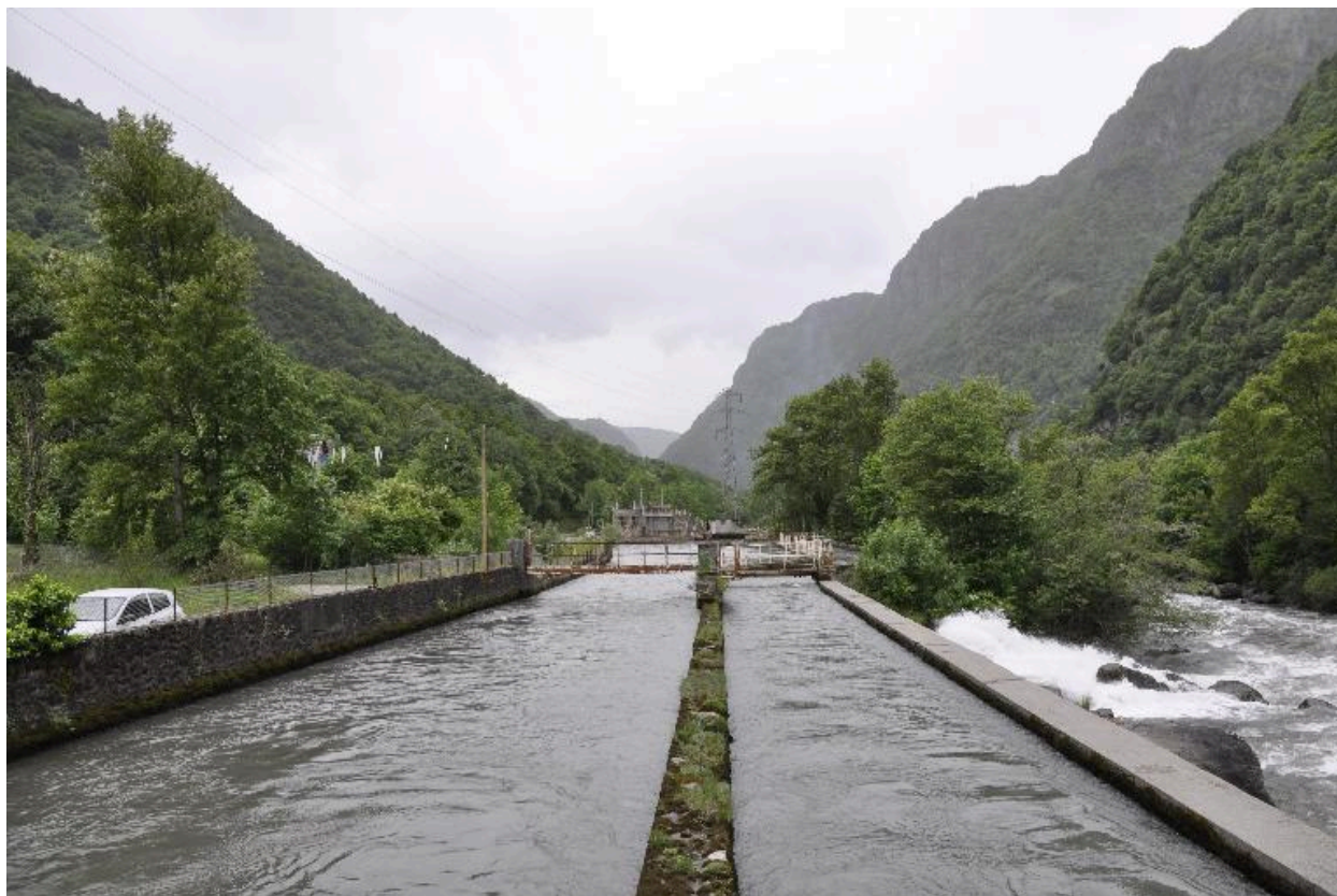
Vue du canal du barrage
