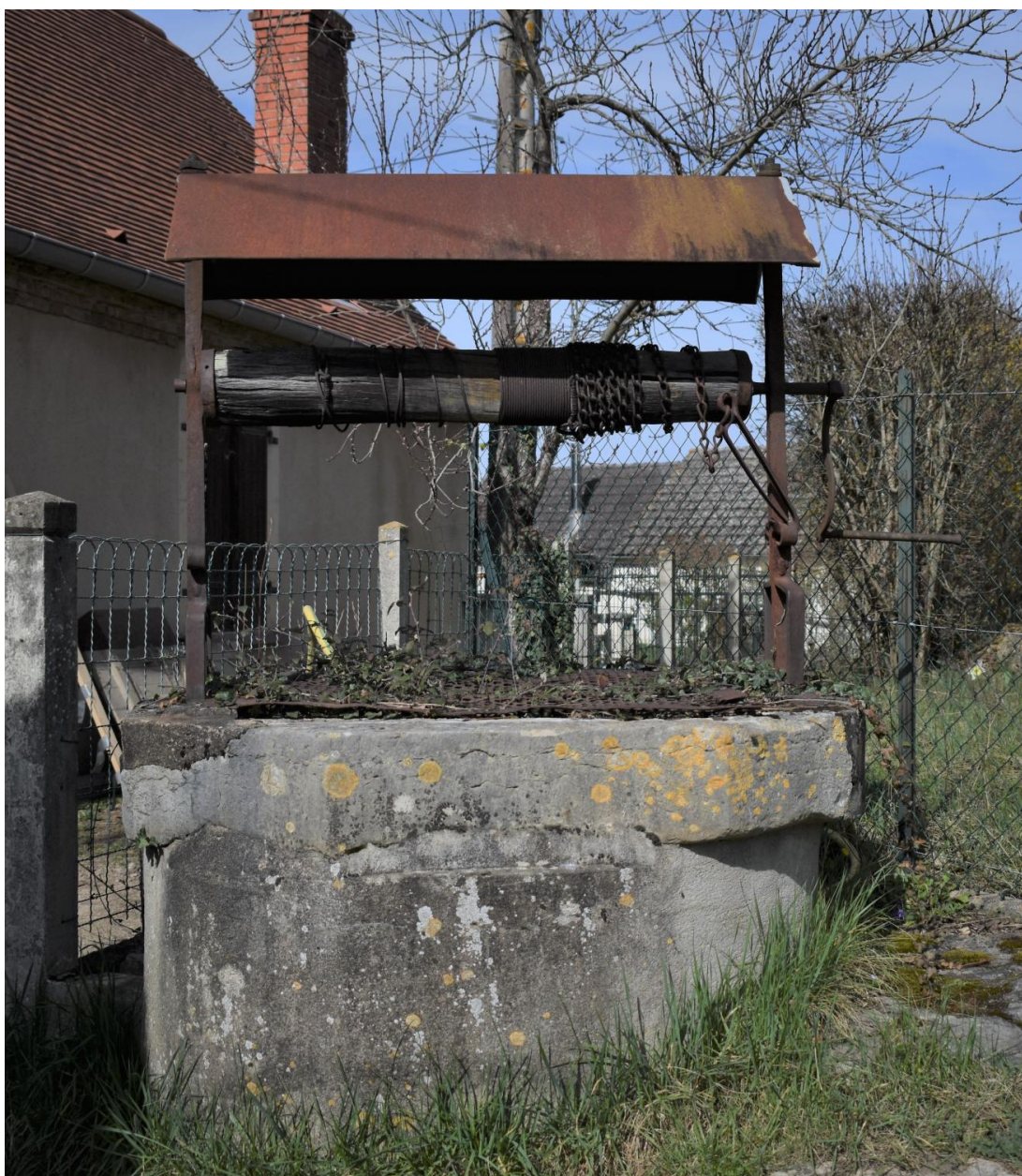
Vue générale du puits de la parcelle 697.
