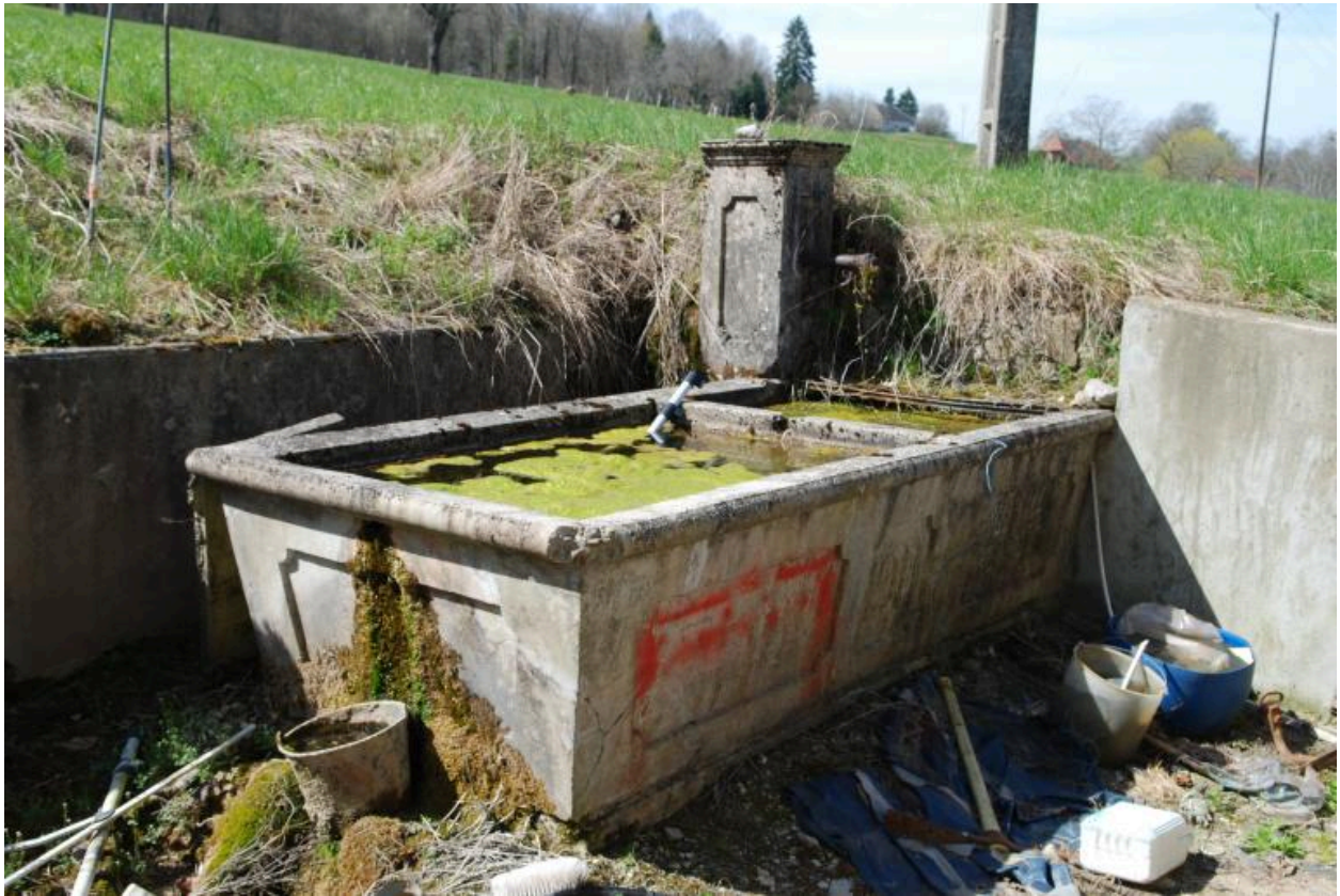
Vue d'ensemble du bassin-lavoir.
