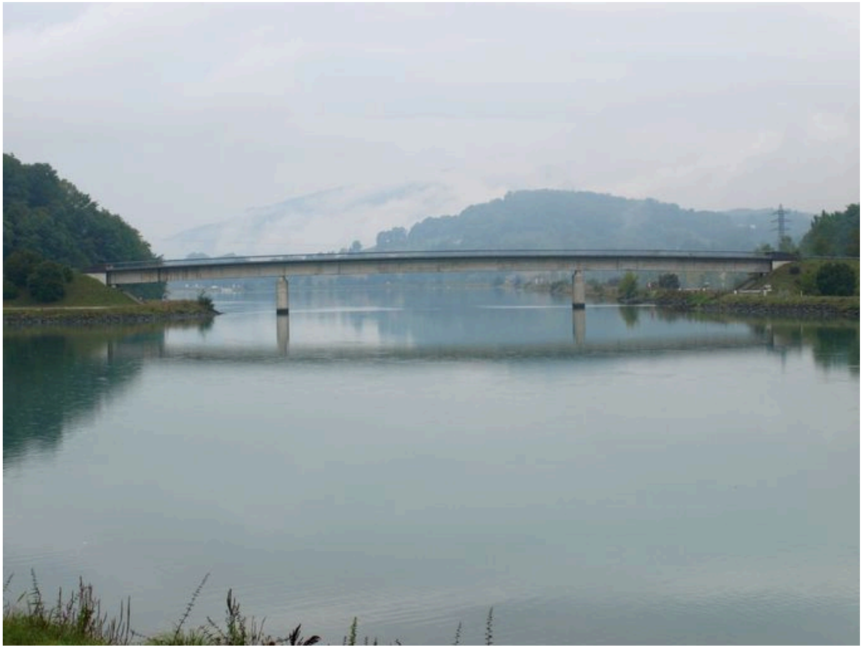
Vue générale, face amont (depuis la rive gauche)
