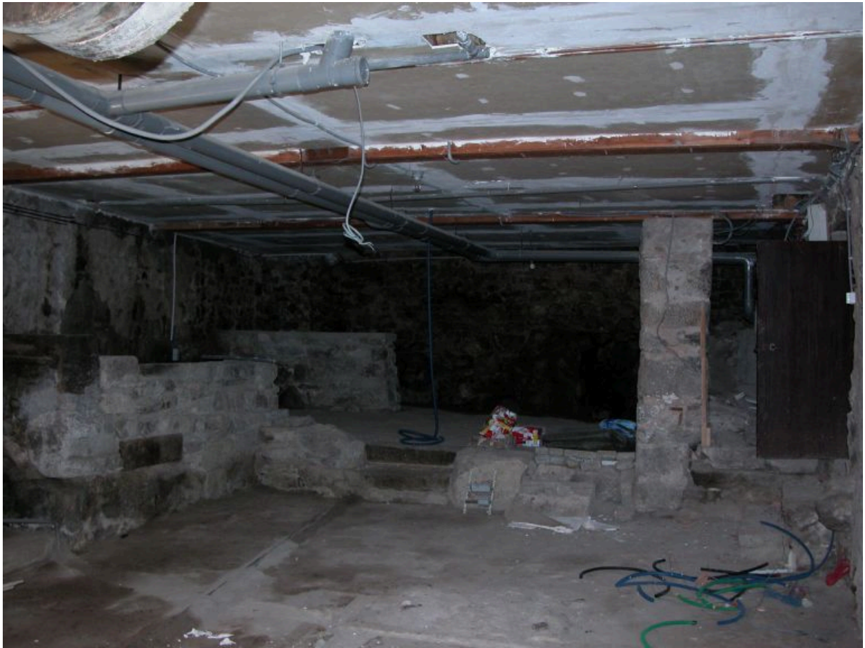
Etage de soubassement, vue intérieure nord.
