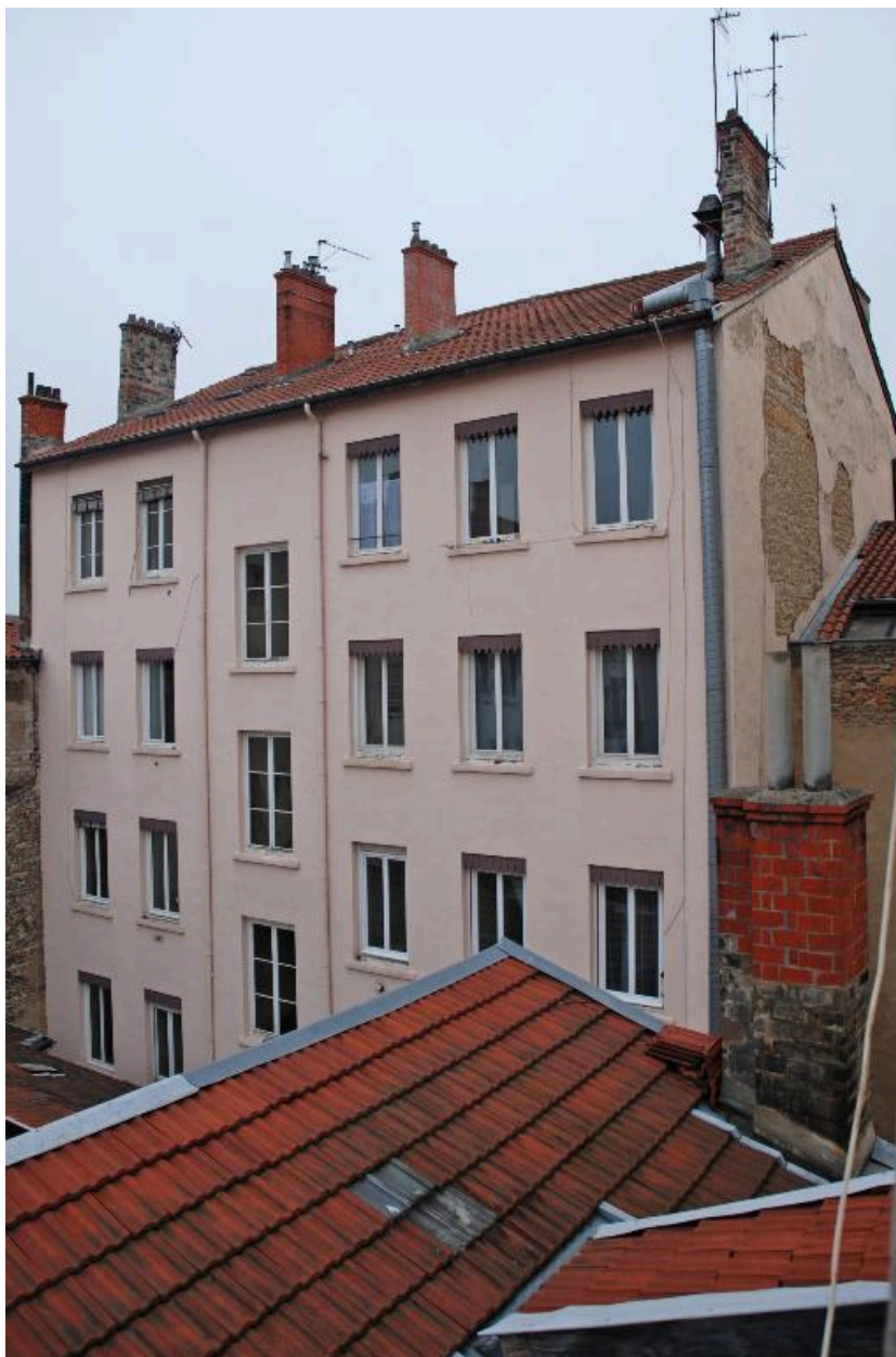
Elévation sur cour, vue générale
