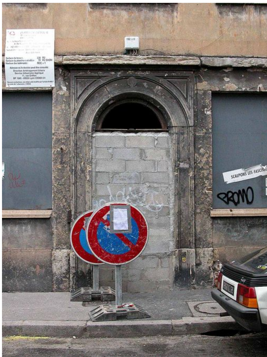
Détail de la porte d'entrée
