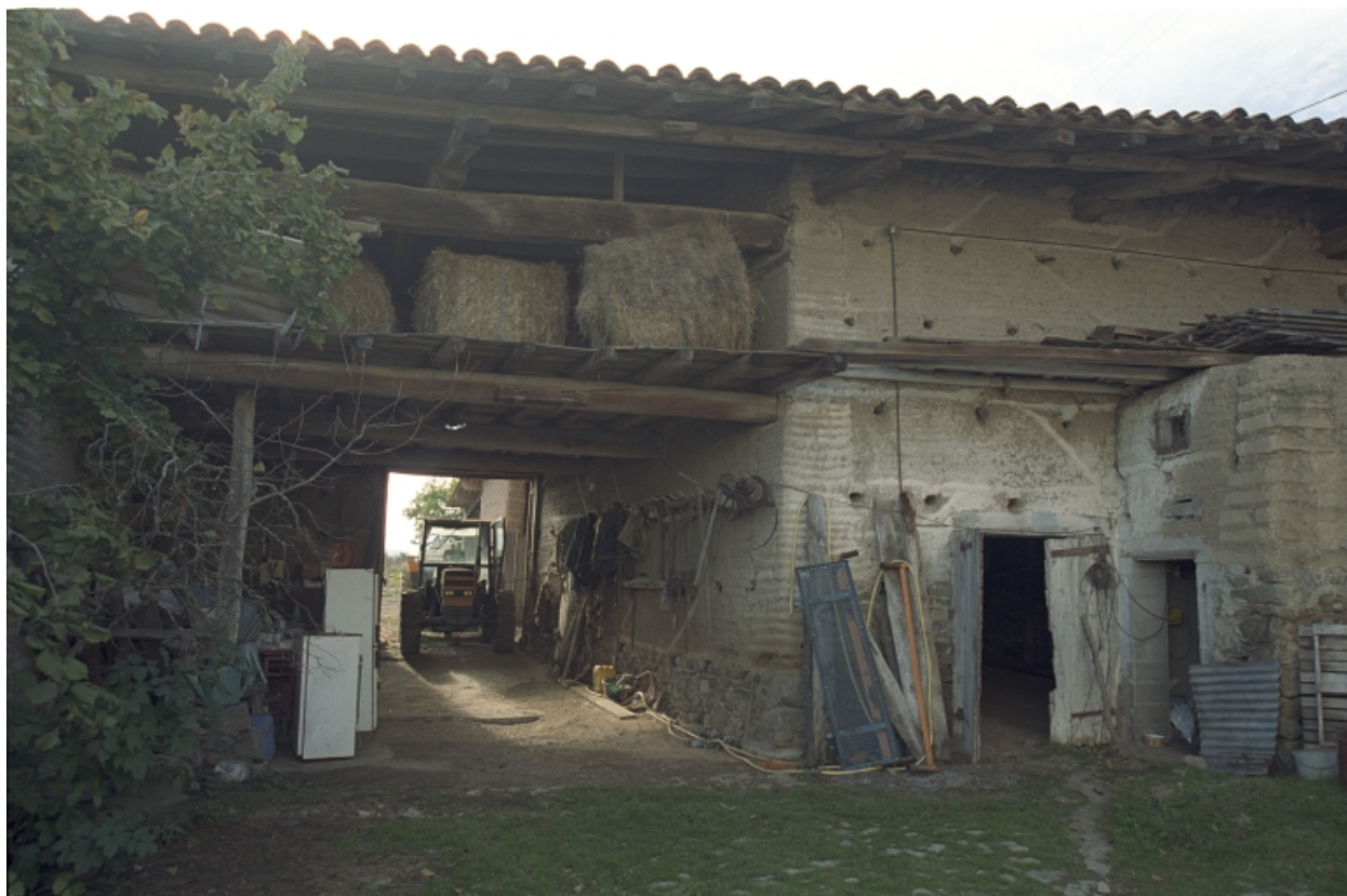
Vue intérieure de la cour, élévation de la grange.
