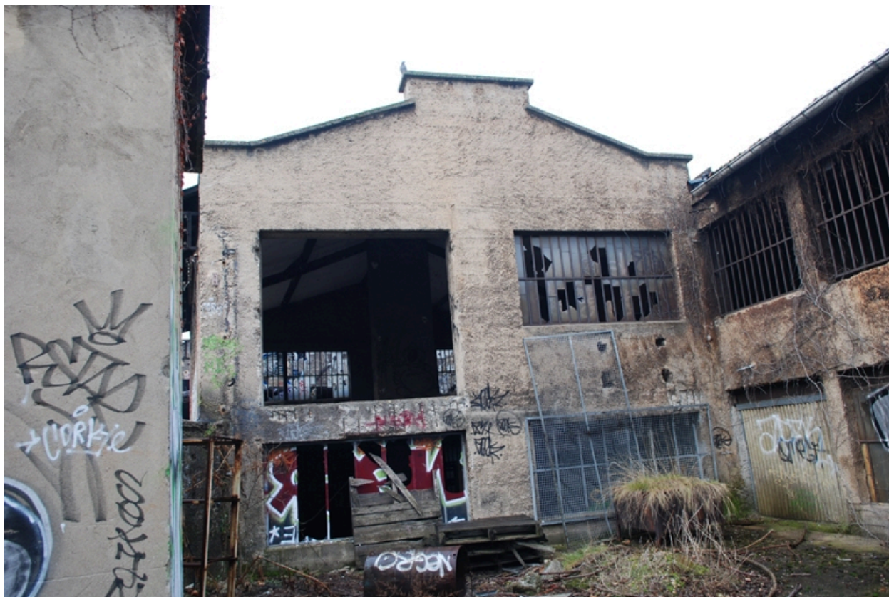
Vue est d'un atelier
