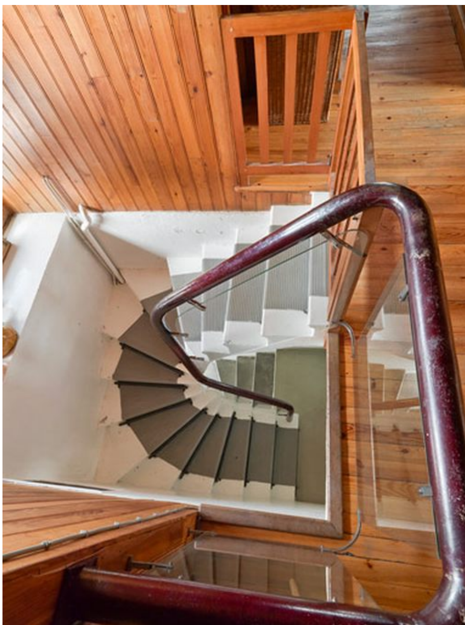
La cage d'escalier
