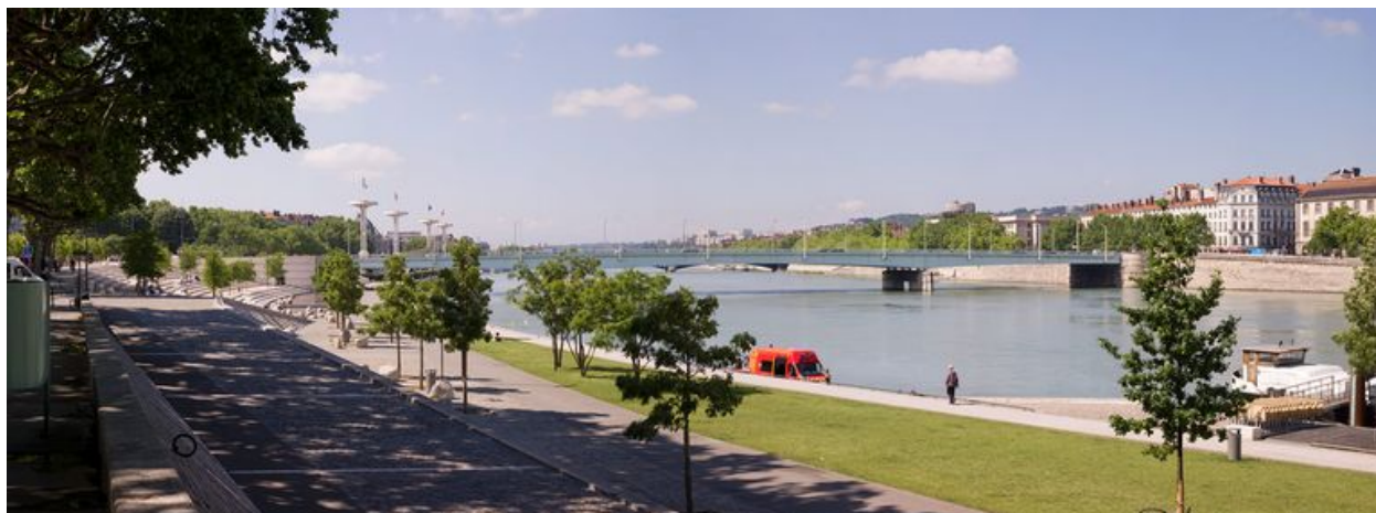
Vue générale, le pont et l'aménagement des berges, face amont (depuis la rive gauche)
