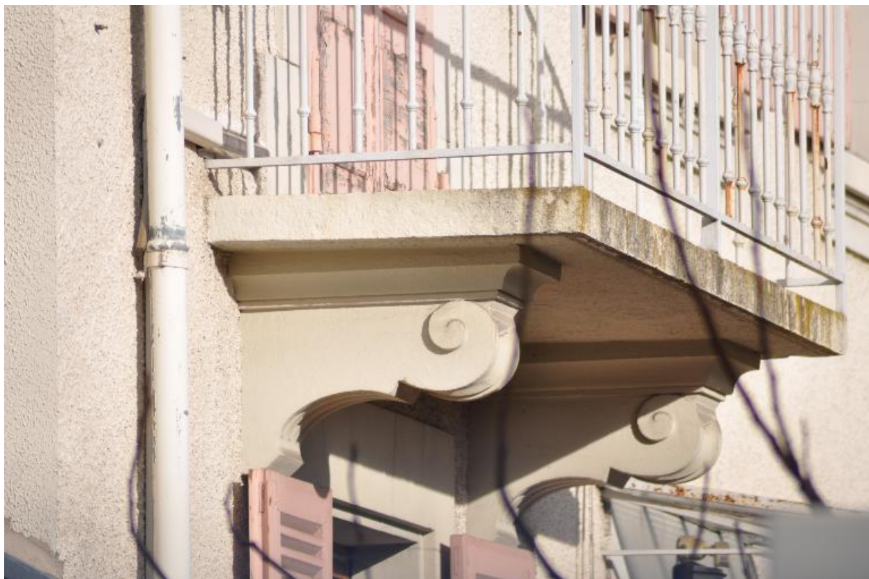
Consoles des balcons
