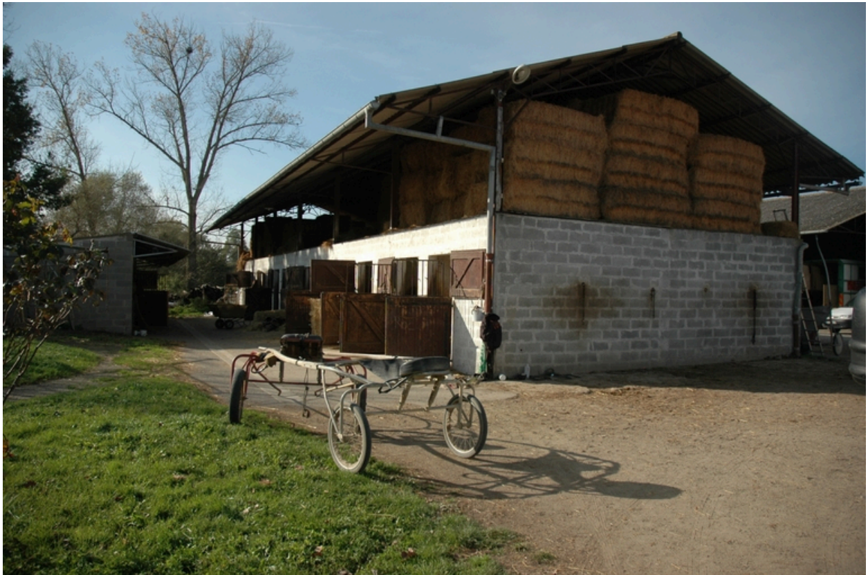
Vue de l'étable à chevaux édifée au sud.
