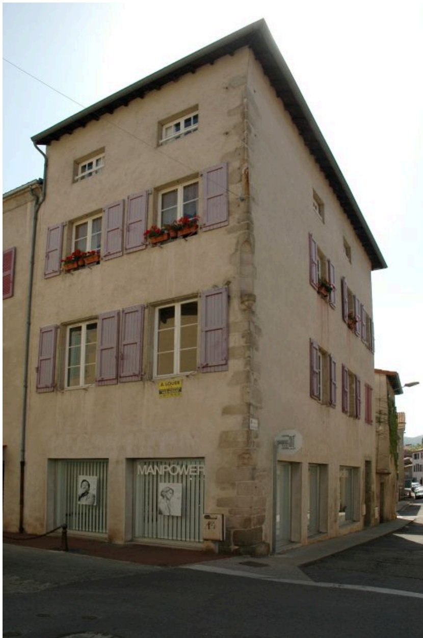
Vue partielle : corps A de trois-quarts depuis la rue Saint-Pierre.
