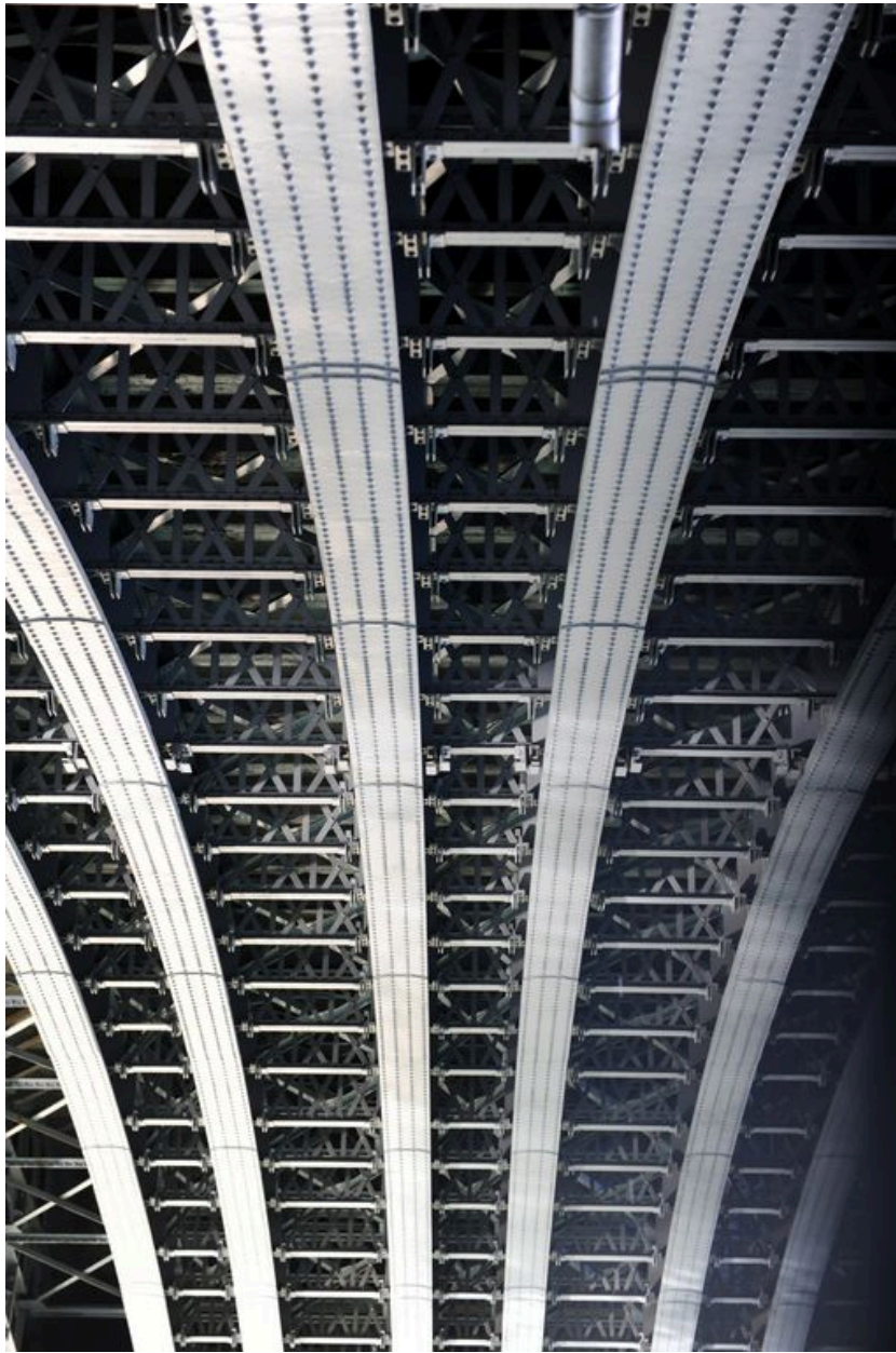
Structure de l'arche gauche, de dessous, vue partielle (depuis la rive gauche)
