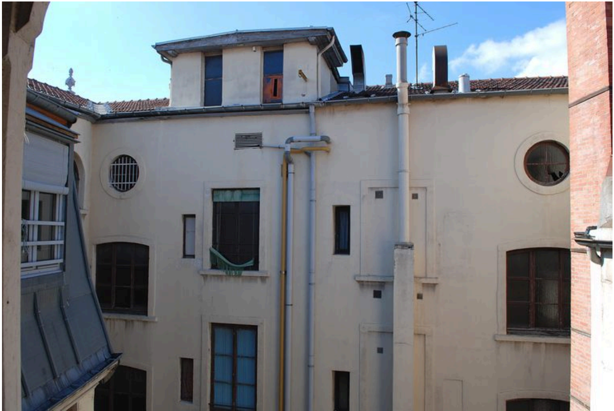
Elévation postérieure : vue partielle depuis la cour de l'immeuble sis 45 rue de Brest
