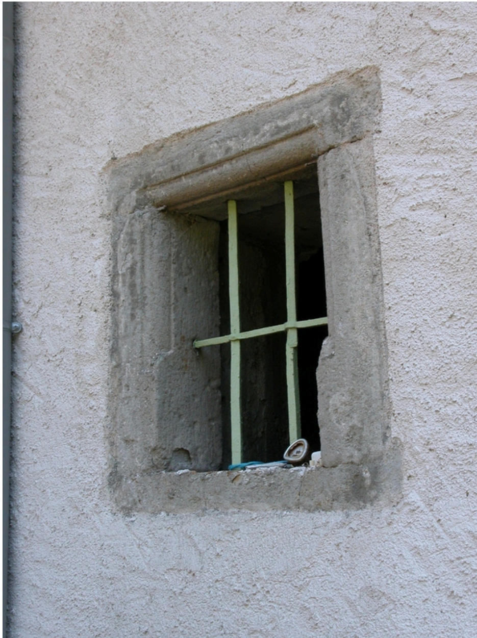
Vue de la fenêtre à gauche de la porte ouest de l'étage de soubassement.
