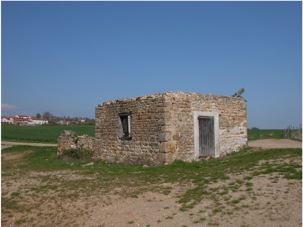
Vue du bâtiment 1984 B 43.
