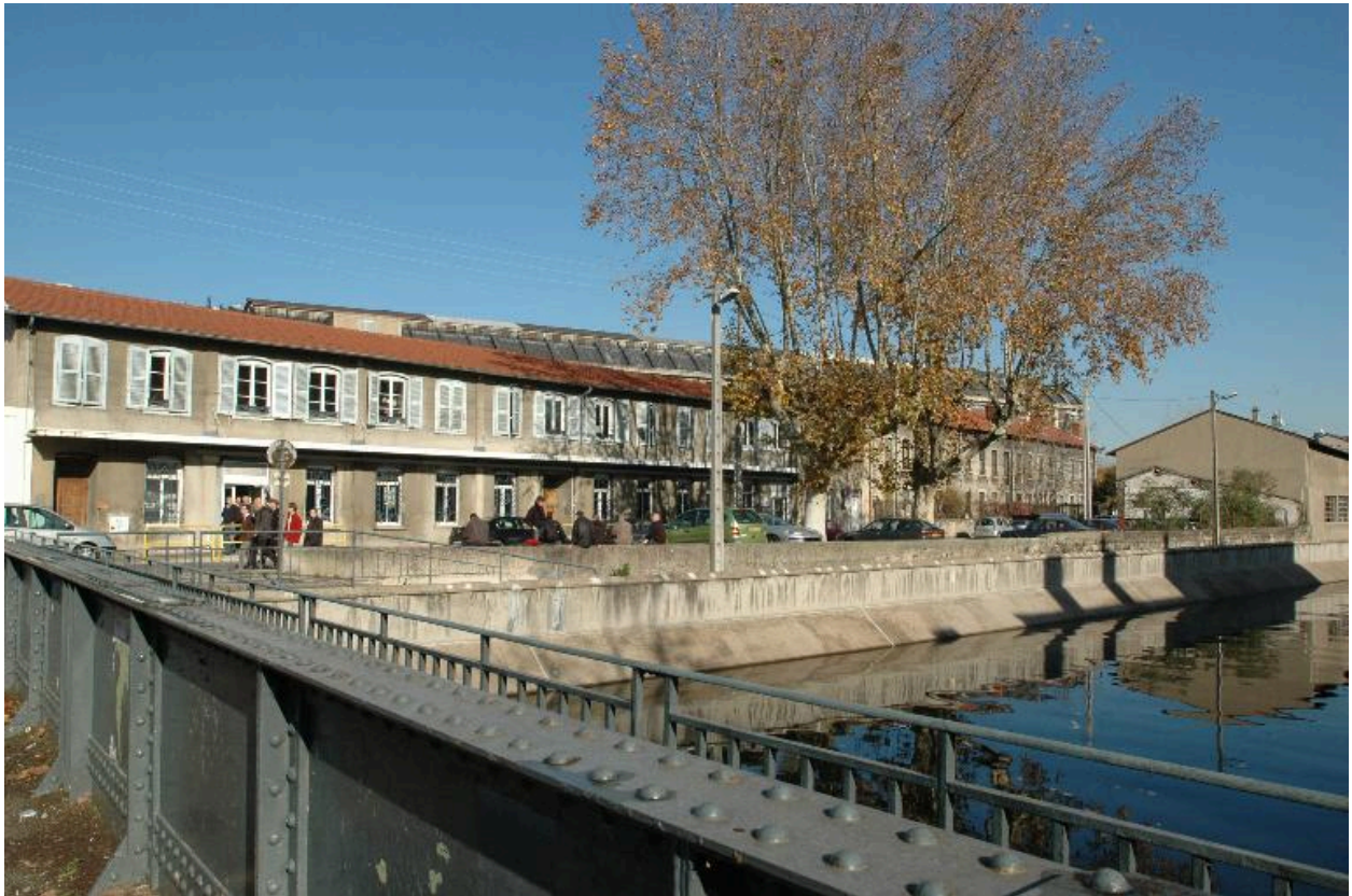
Vue façade sud, service social, foyer, cantine... (en bordure de l'Izeron)
