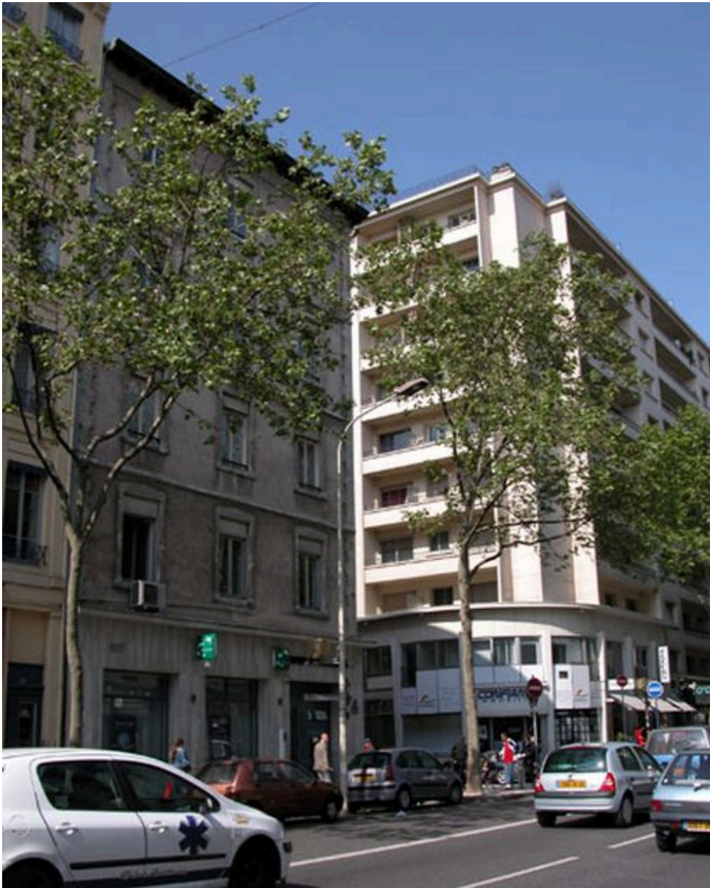
Vue partielle depuis le nord-est
