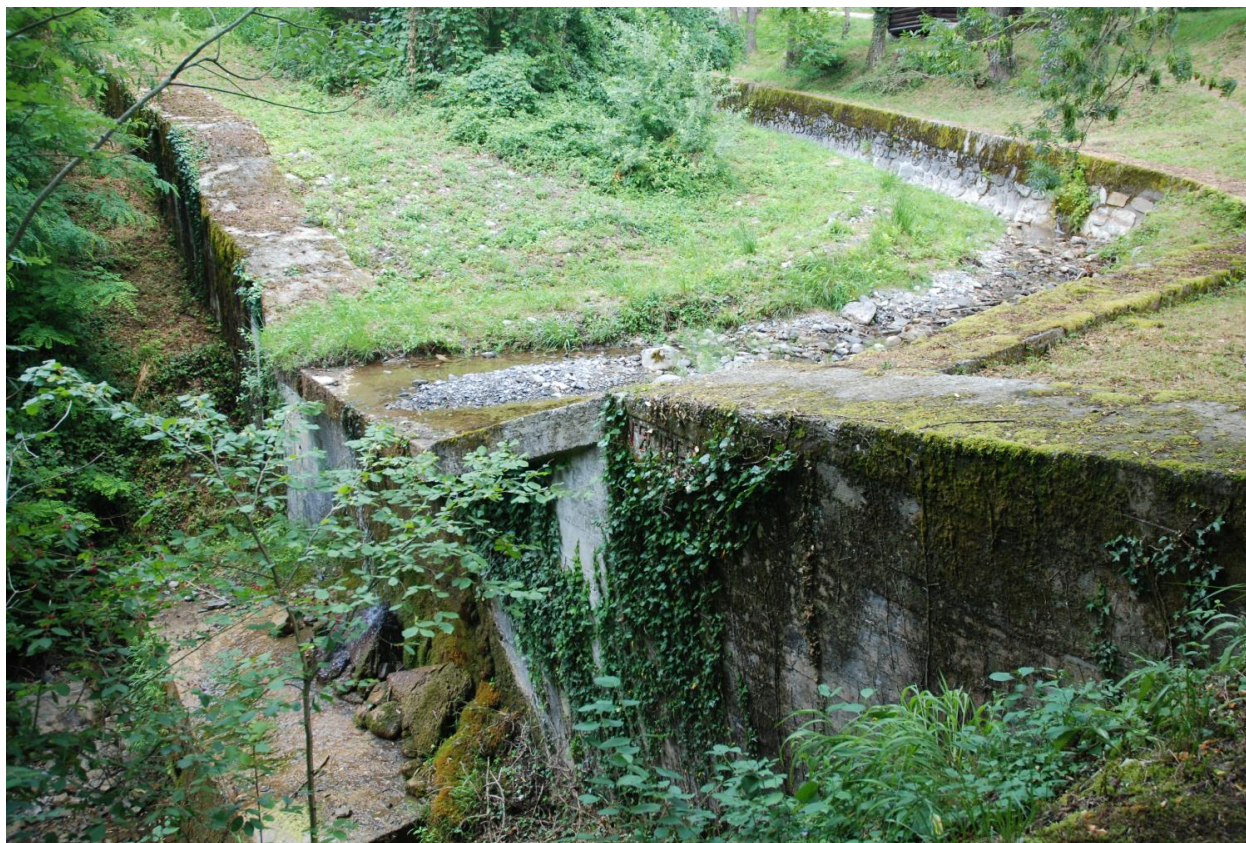
Aménagements du Gargot au niveau des Coutins.
