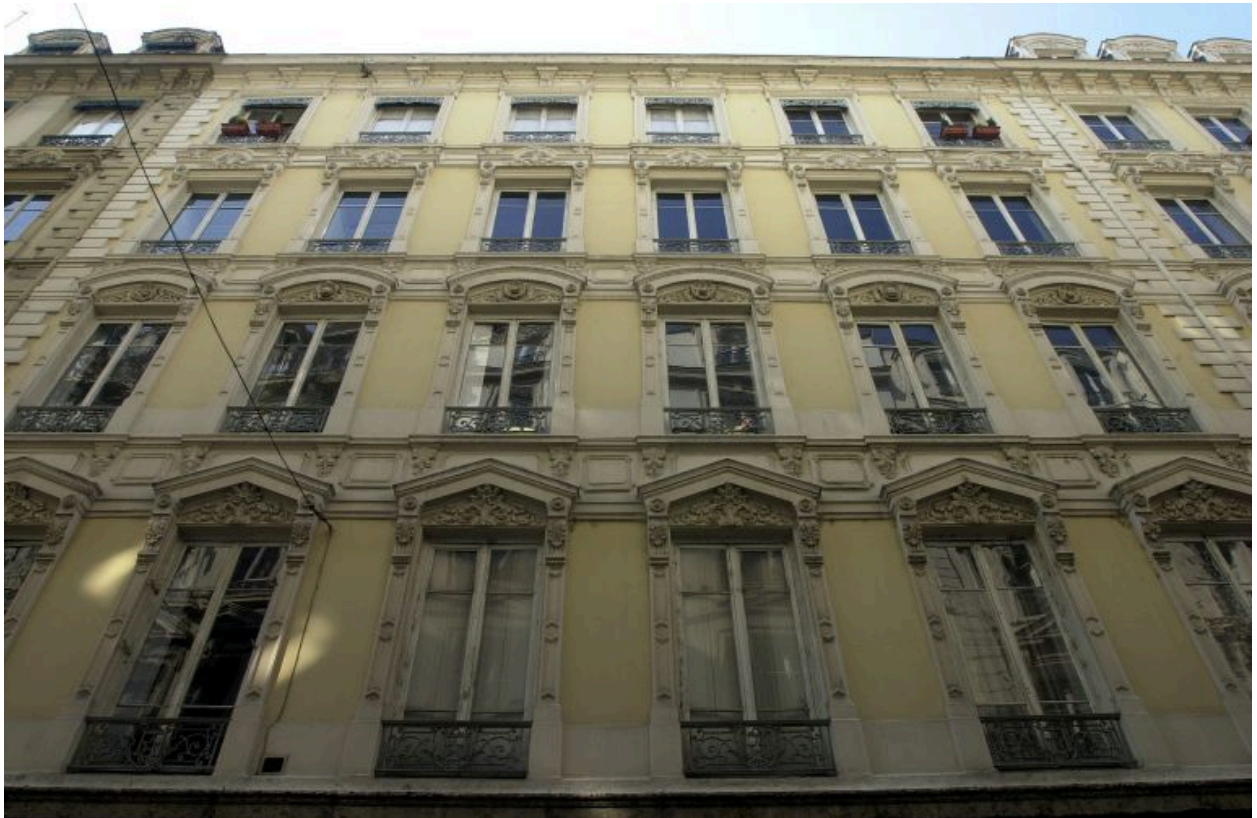
Façade rue Longue, travées centrales
