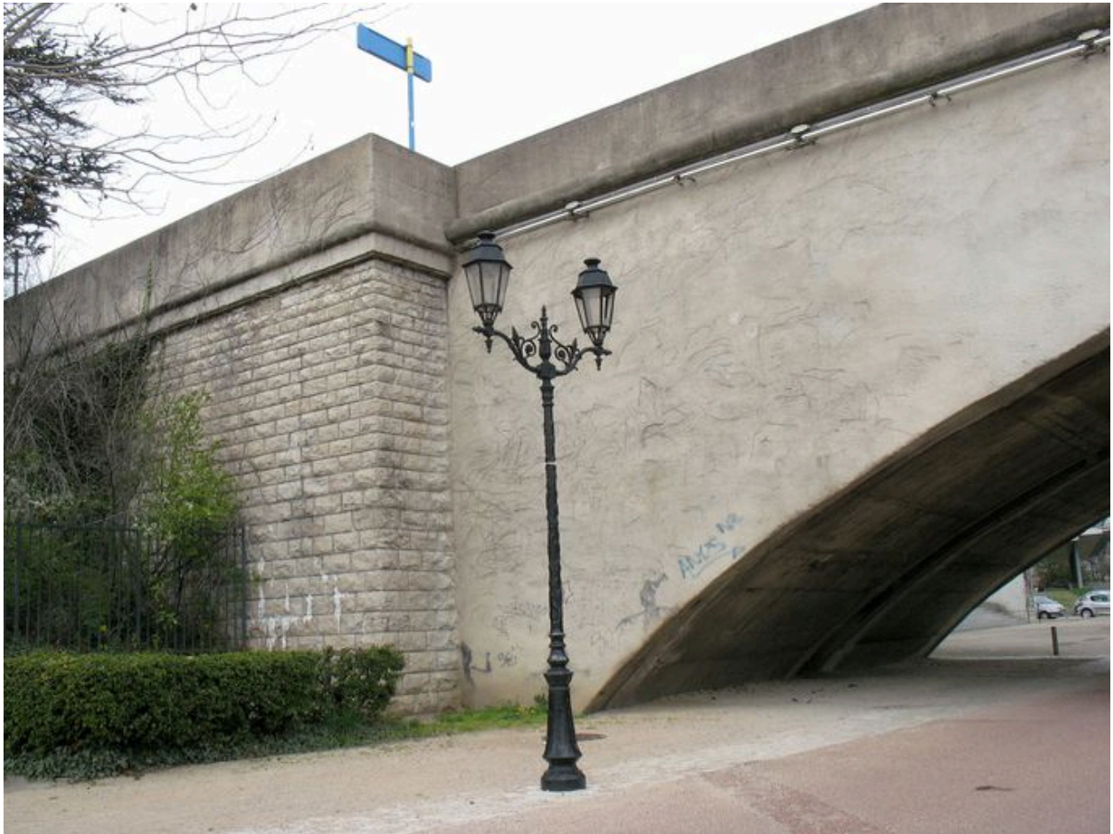
Vue partielle de la culée, rive droite (face aval)
