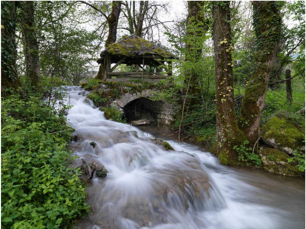
Vue générale du moulin en bordure du ruisseau de la Monderesse.
