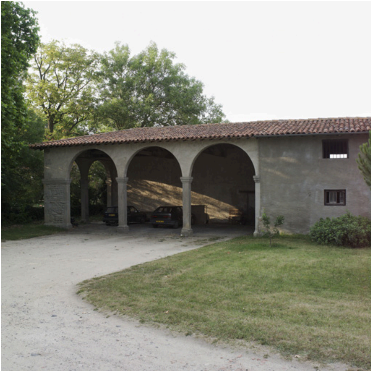
Vue intérieure de la première cour : remise à arcades.
