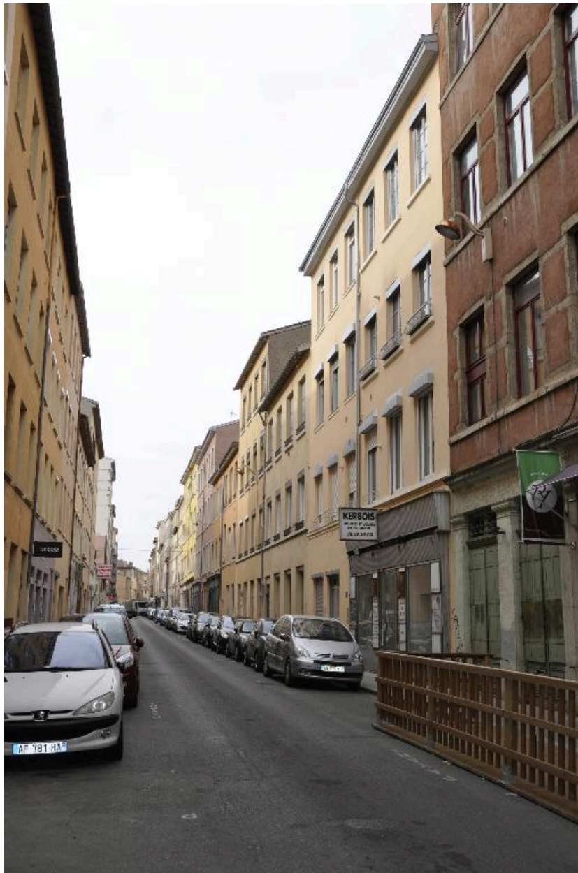
Vue d'ensemble nord est de la rue du Mail
