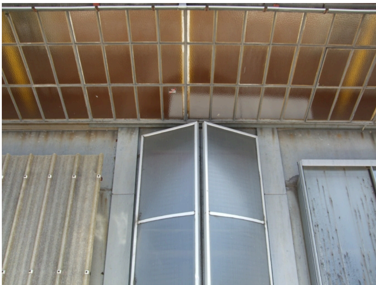
Verrière et éclairage zénithal
