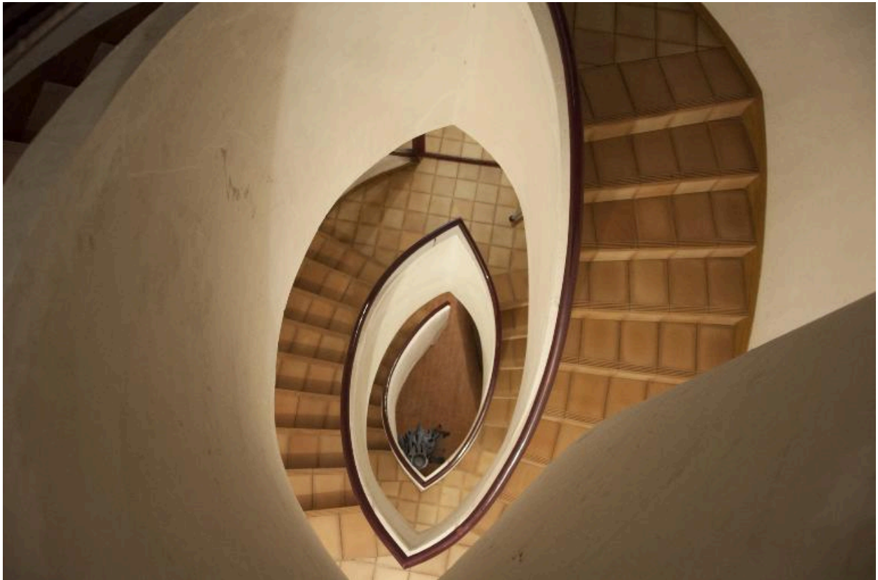
Vue de l'escalier de distribution depuis le haut
