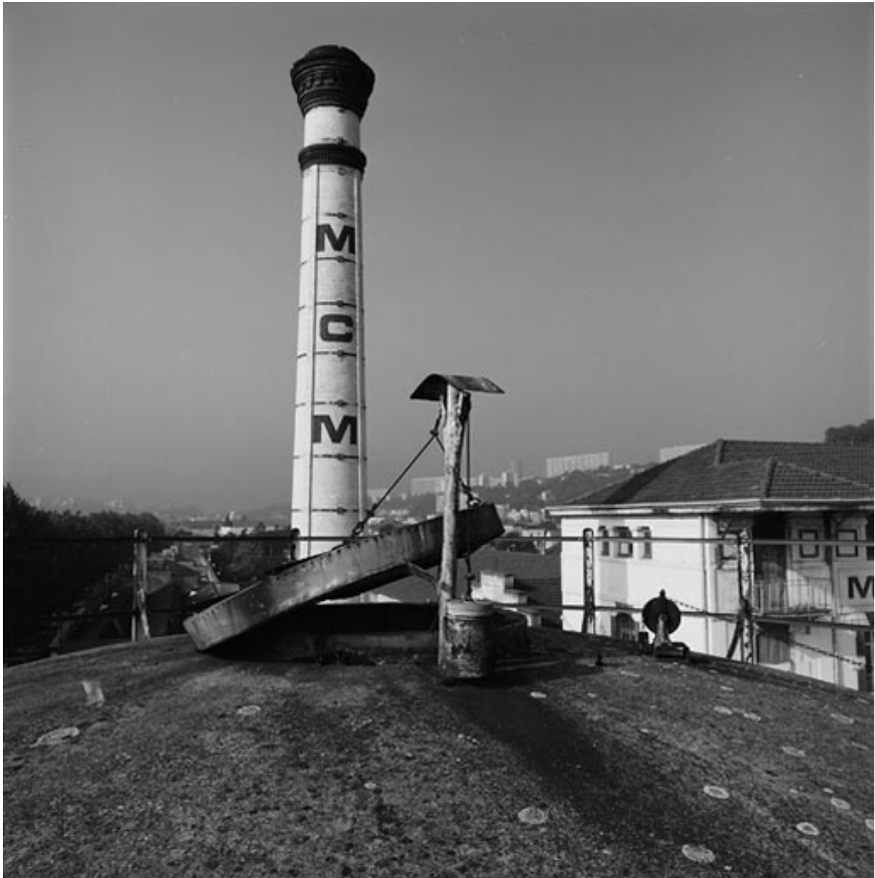
Château d'eau, vue d'en haut
