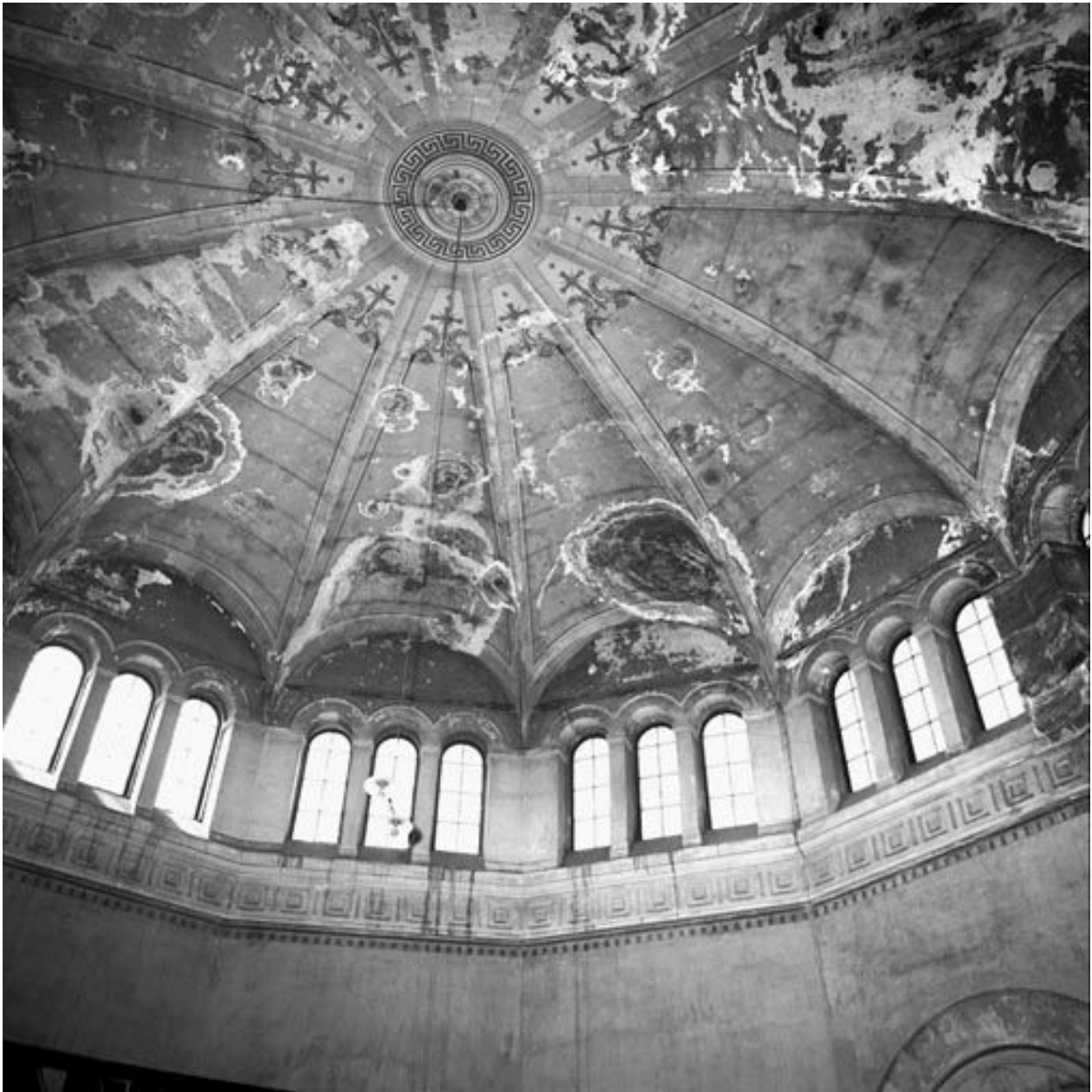
Chapelle : vue partielle de la coupole, état en 1984
