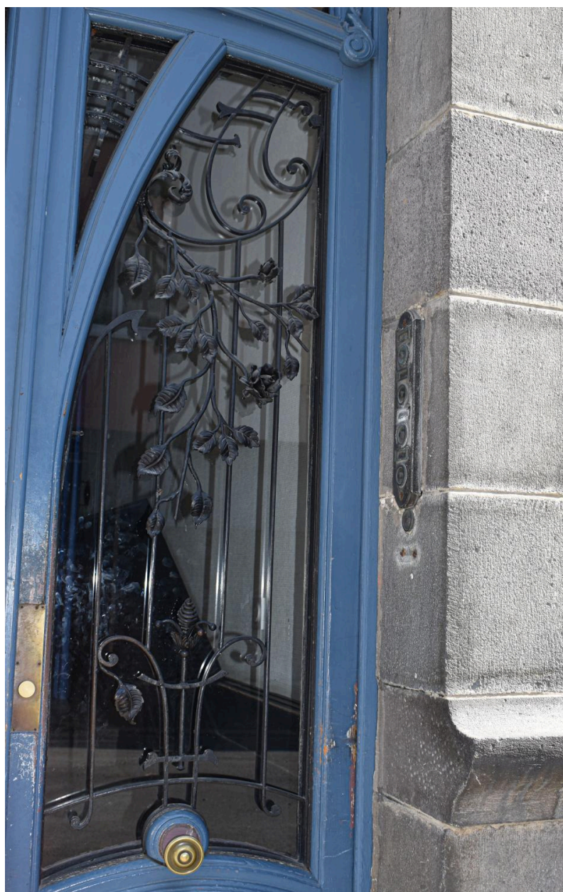
Ferronnerie de la porte d'entrée
