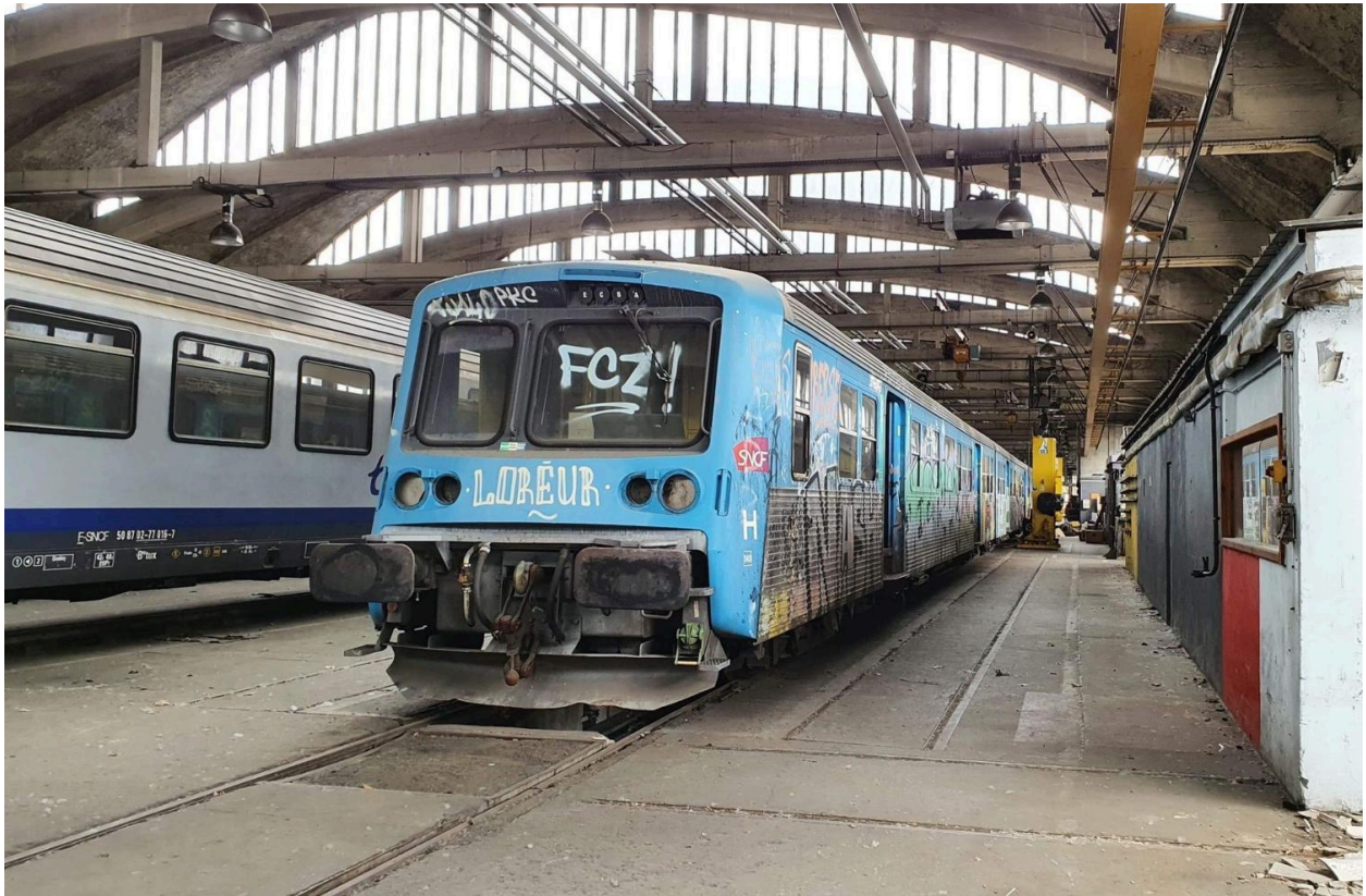
Vue intérieur de la halle de lavage, sheds béton.
