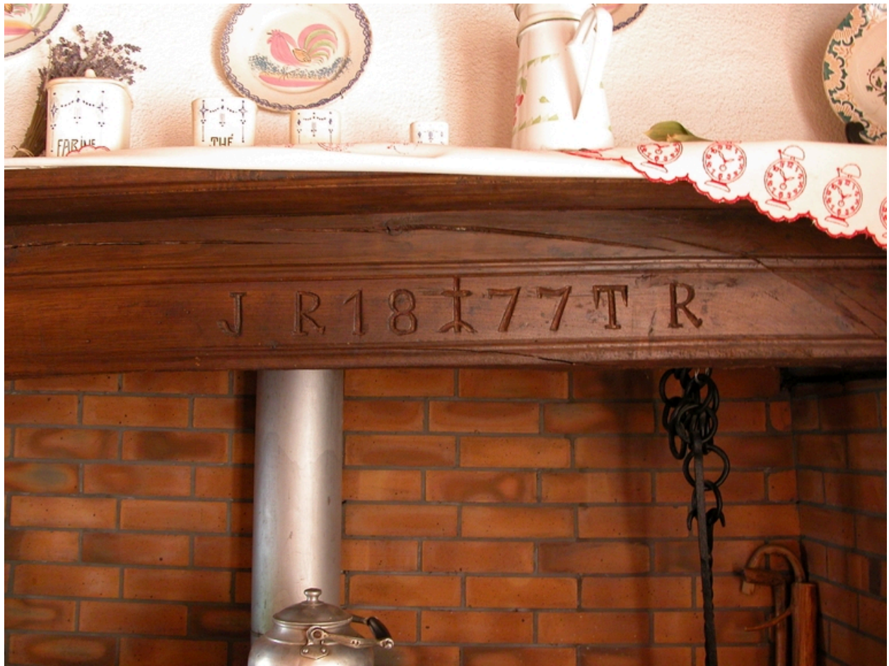
Linteau de la cheminée de la cuisine du logis occidental.
